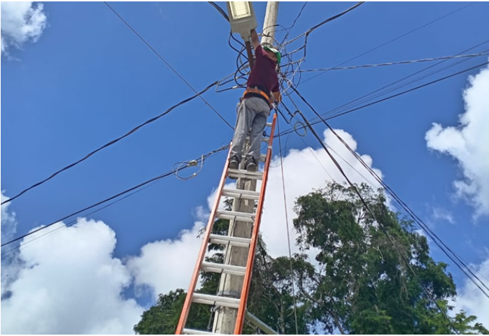
magen. Reparación, mantenimiento y cambio de luminaria y fotocelda.
