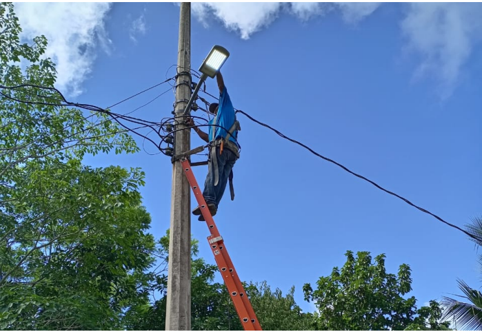
magen. Reparación, mantenimiento y cambio de luminaria y fotocelda.
