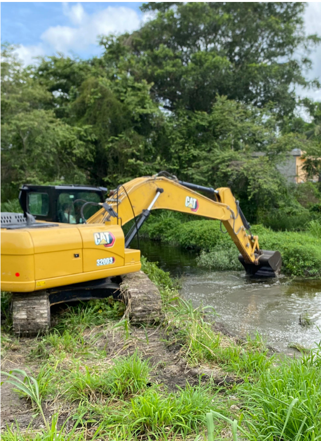
Imagen. Desazolve del canal del canal de la Colonia Bugambilias
