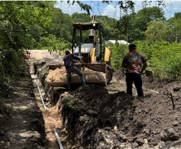
Imagen. Instalación de tubería para agua potable en la localidad de Cristóbal Colón.
