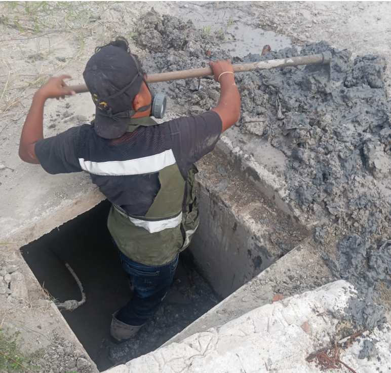
Imagen. Limpieza y mantenimiento del alcantarillado municipal.
