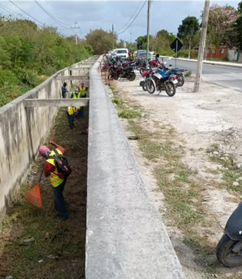
Imagen. Limpieza y desazolve del canal de desagüe del jagüey comunitario.
